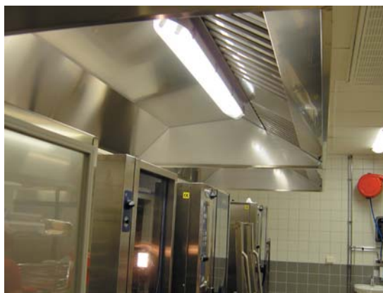
Detalj av filter i kåpans framkant
