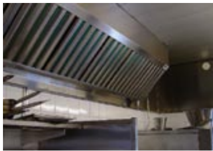
Filterhus FVU i en kökskåpa
