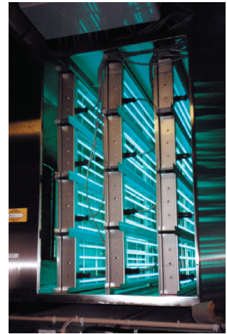
FLOK med öppen servicelucka. Obs. Luckan får ej öppnas om UV-lamporna lyser eftersom det blå ljuset kan skada ögonen.
